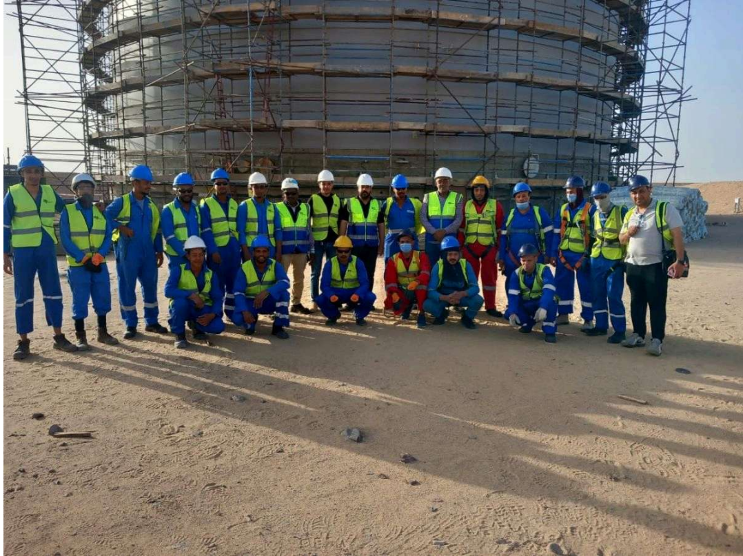
Montageteam vor einem großen Lagertank während Isolierarbeiten. INP Egypt LLC
